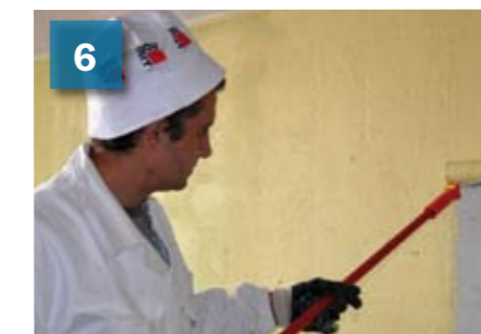
Baumacol Proof felhordásával biztosított a fröccsenő víz elleni szigetelés.
